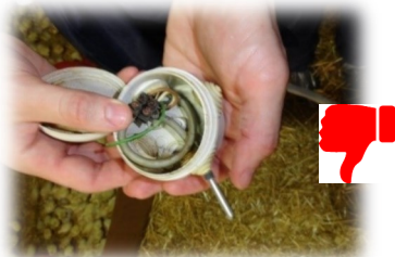
Exemple de mauvaise étanchéité
