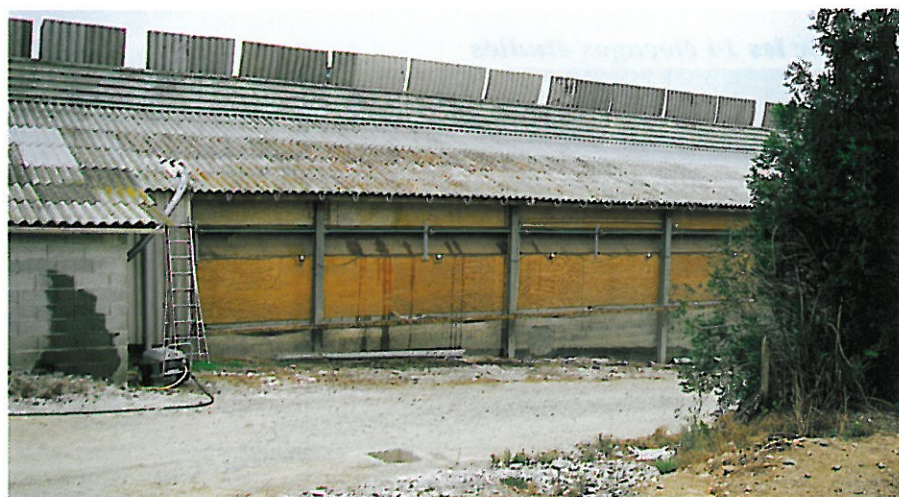
Démontage des jupes et du lanterneau du bâtiment avant son nettoyage
