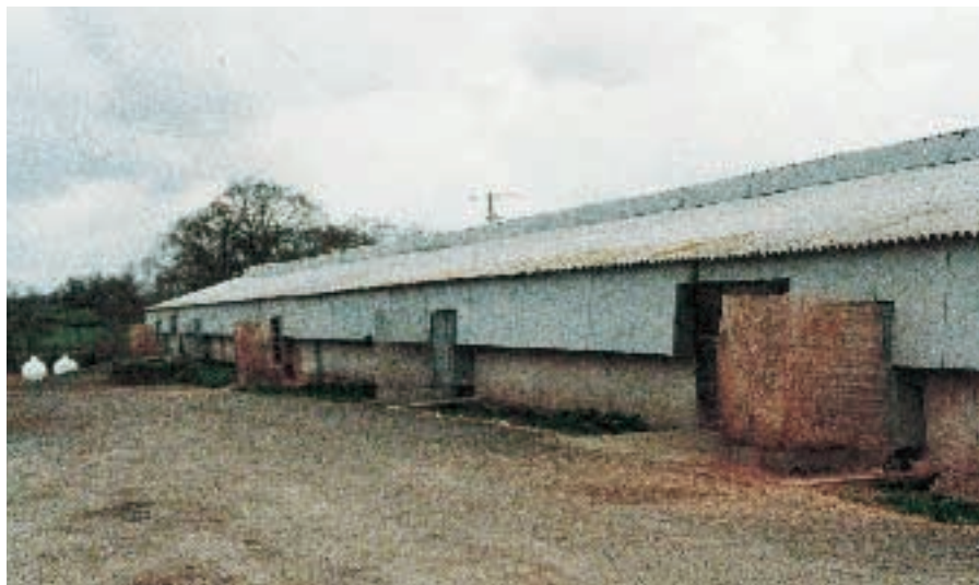
Les poussières émises par les bâtiments d'élevage peuvent représenter des quantités importantes. On les voit ici, bloquées sur des grillages à la sortie des ventilateurs.
